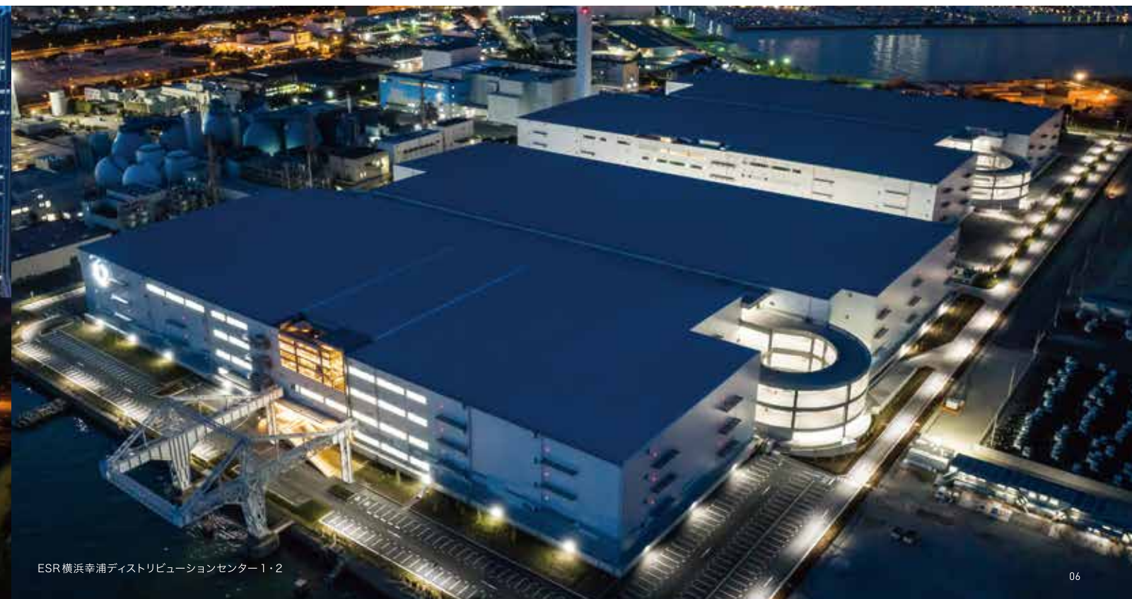
ESR 南港 OS1 データセンター
