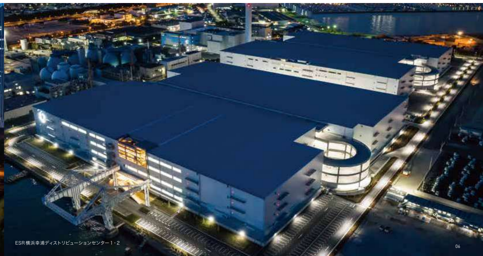
ESR 南港 OS1 データセンター
