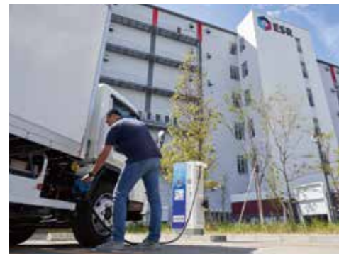
尼崎DCの高速充電ステーション
